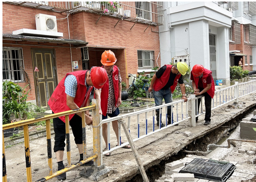
霞浦街道凤凰社区第一时间组织党员志愿者，对施工围挡及周边路面进行加固防护
