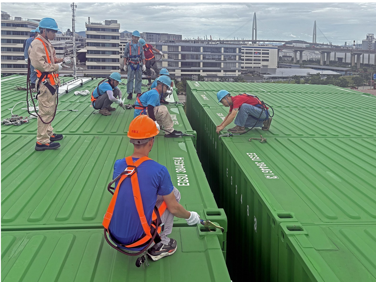
柴桥街道芦江工业社区内的企业工人加固集装箱堆放场地
