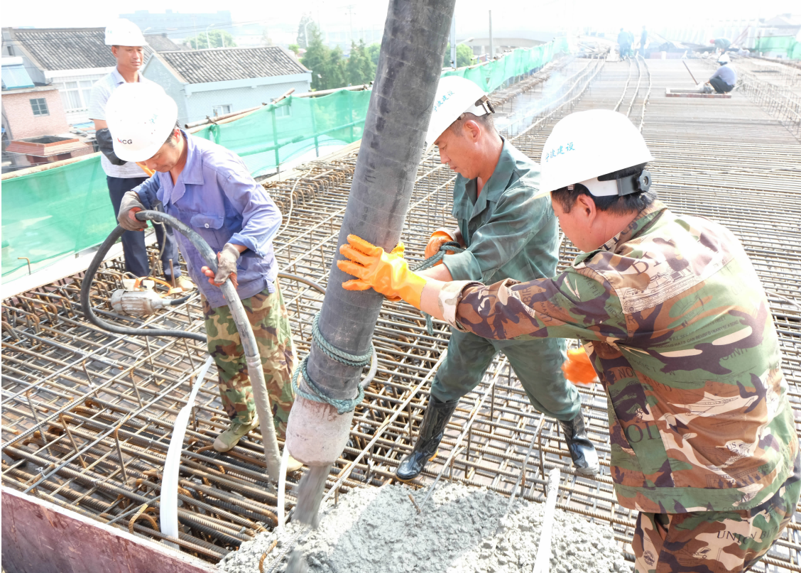
图为建筑工人正在浇筑箱梁混凝土。（记者 孙红军 摄）
